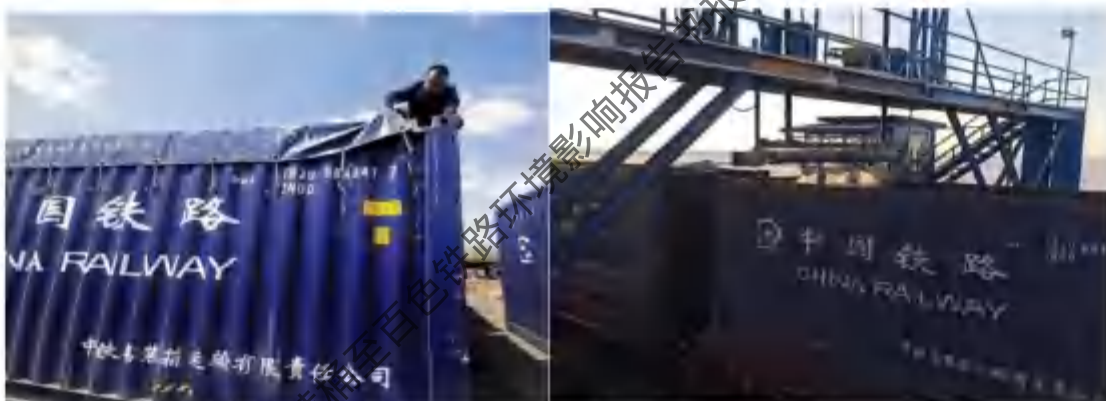
覆盖（左）及喷洒抑尘剂（右）示意照片
