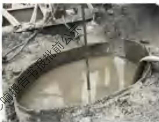
桥梁灌注桩基础施工
